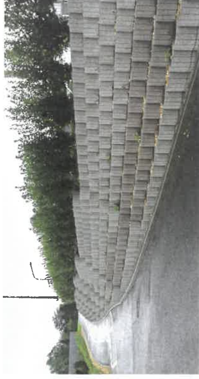
SOLUTION DE BASE: SOUTÈNEMENT EN BLOC BÈTON
