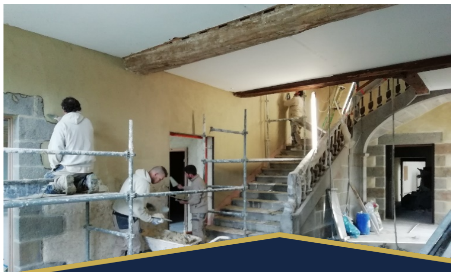
Pose de l'enduit chaux-chanvre dans le hall
