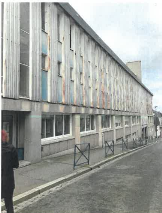
Vue de la façade existante depuis la rue des Halles
