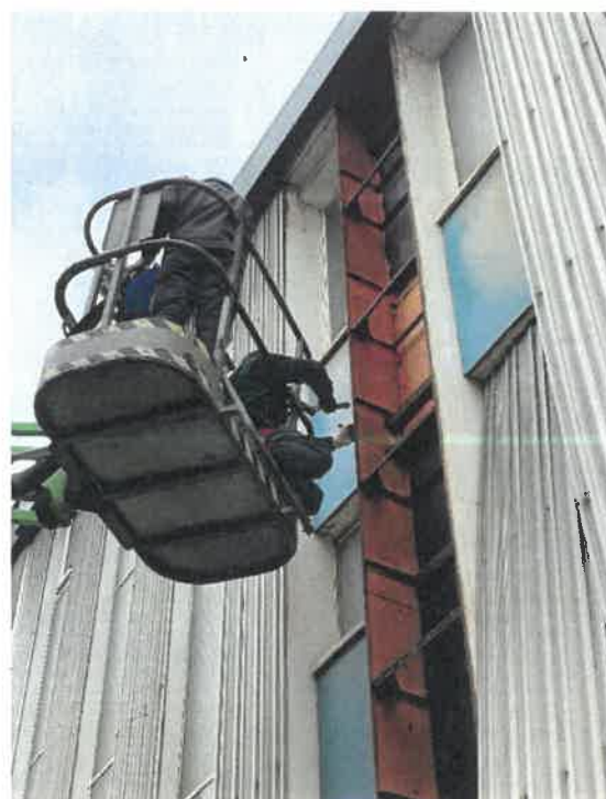
Vue du démontage d'une trame de connexion lors de la campagne de sondages
